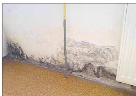
Das in den Kapillaren aufsteigende Wasser führt schädliche Salze aus dem Erdreich und den Baustoffen mit sich. Diese Salze lagern sich im Mauerwerk ab. Durch ihre hygro-
